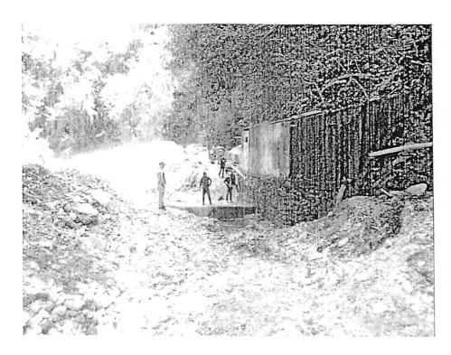
OBRA: Rehabilitación Acueducto Paraíso - Ojeda Vista del movimiento de tierra para la colocación de la tubería de∅"8 Acero SCH-40 Foto d/f 04/04/2019
