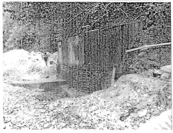
OBRA: Rehabilitación Acueducto Paraíso - Ojeda Vista del movimiento de tierra para construcción de ataguía (desvió de rio) Foto d/f 04/04/2019
