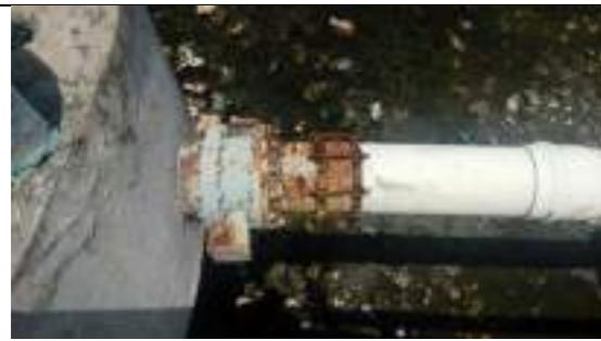
**Foto 08:** Oxidación de elementos metálicos.
